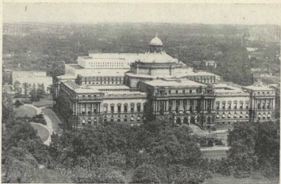
Library of Congress (Kongresna knjižnica) v Washingtonu, glavnem mestu Zedinjenih držav Severne Amerike. V ospredju je glavno poslopje knjižnice in za njim moderni prizidek. Knjižnica zaposluje nad 2500 uslužbencev in ima nad 30 milijonov kosov (knjig, zemljevidov, fotografij, fotokopij, mikrofilmov, mikrokart itd.)
