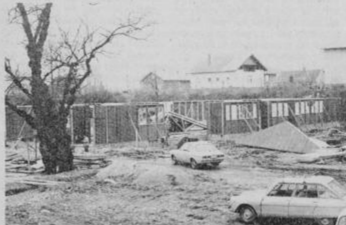
Novi vrtec Turmische-Hajdina bo že v drugi polovici tega leta sprejel 120 varovancev. Dela na gradbišču dobro napredujejo. Foto: R
