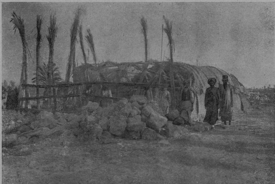
Iz Mezopotamije: Perzijska hiša v puščavi, zgrajena iz ilovice, kamenja in plaht.
