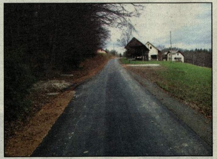
Del na novo asfaltirane ceste
