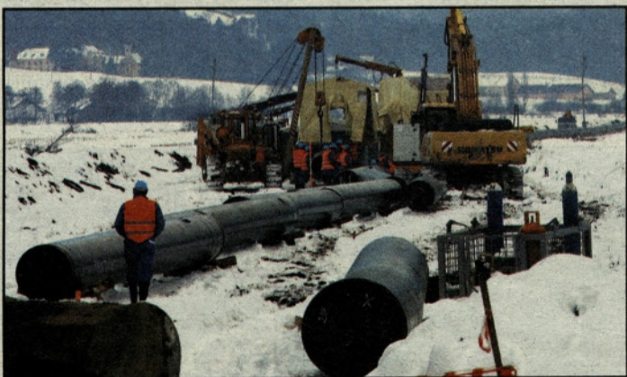
Gradnja plinovoda v občini Polzela
