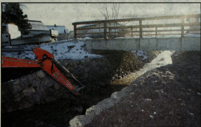
Obnovljen most in urejanje brežine
