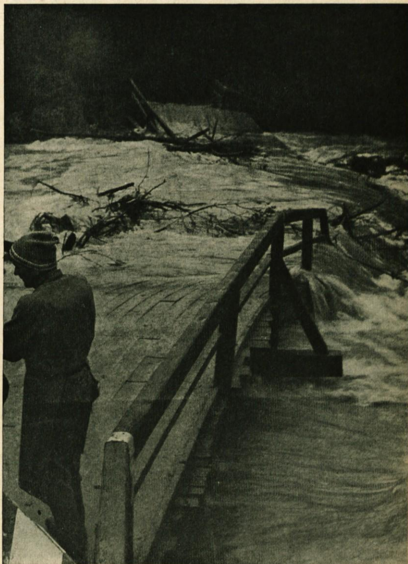
Kamniška Bistrica je dosegla najvišjo gladino in preplavila mostno konstrukcijo
