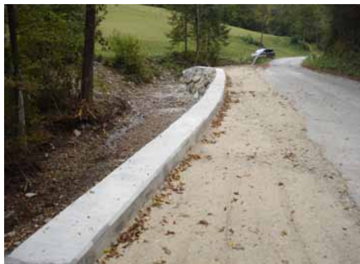
cesta Blagovica – Češnjice (ob vodotoku)
