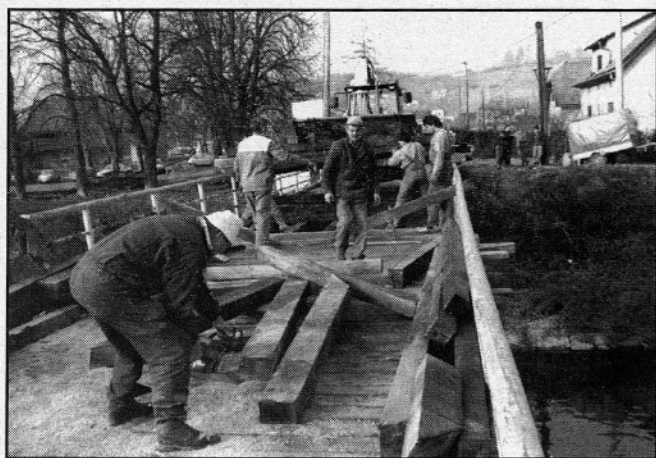
Obnova lesenega dela mostu (foto: Ciril Sem)
