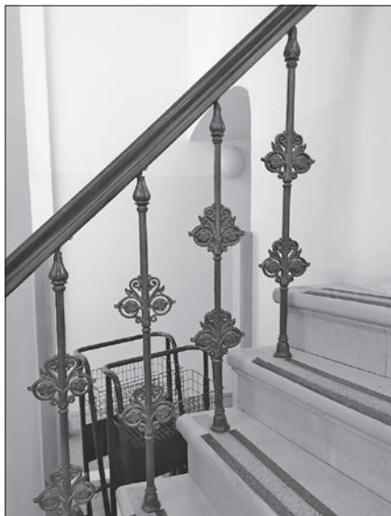
Slika 11: Litoželezna stopniščna ograja ljubljanske železniške postaje (foto: Simona Kermavnar).
