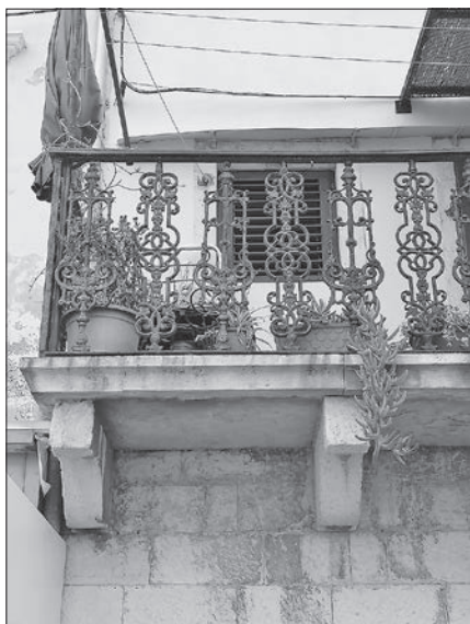
Slika 13: Litoželezna ograja konzolnega balkona na Gregorčičevi ul. 25 v Piranu (foto: Simona Kermavnar).
