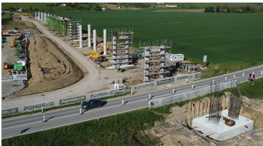
Slika 2 • Viadukt Pesnica, maj 2021.
