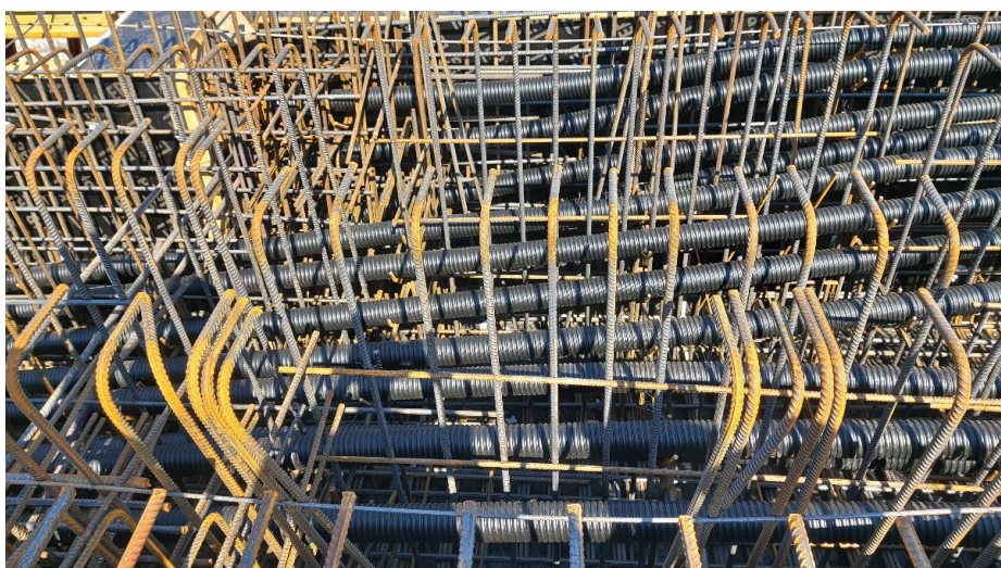
Slika 4 • Kableske cevi in armatura rebra, junij 2021.
