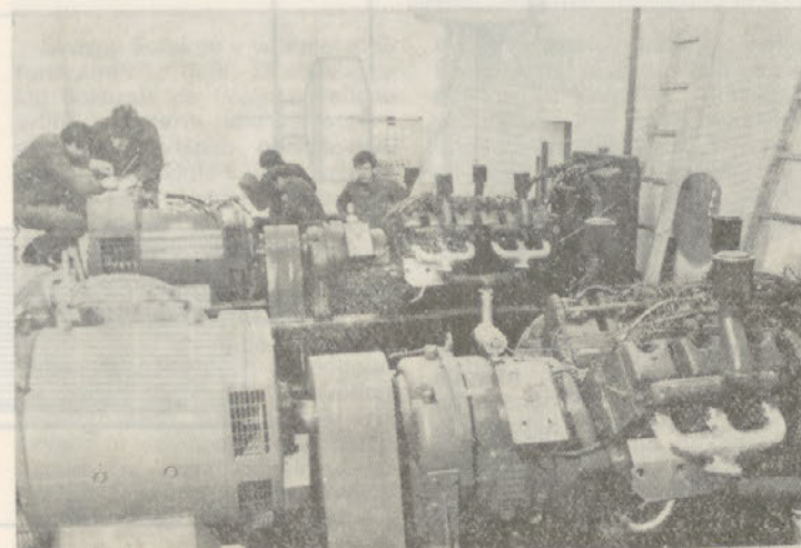
Montaža agregatov za proizvodnjo lastne električne energije
