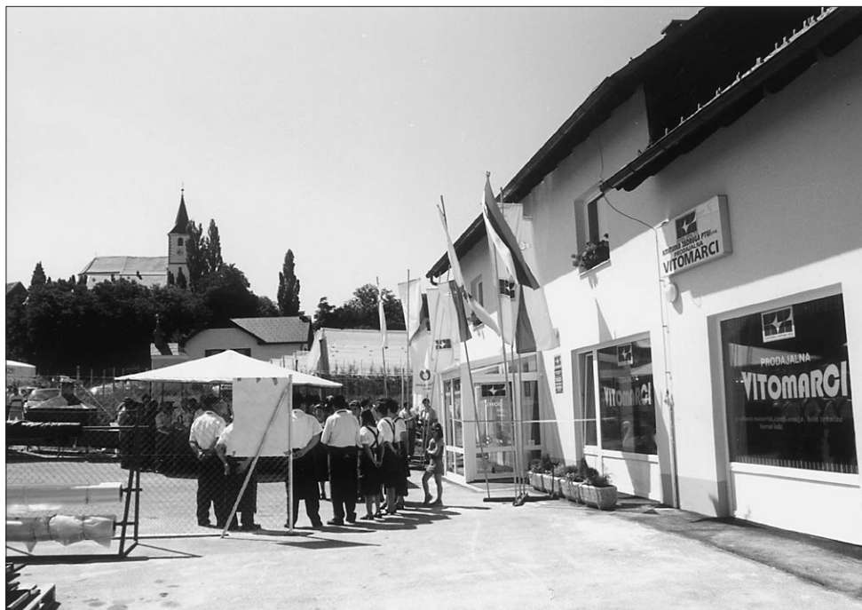
Prenovljen zadrughni objekt v Vitomarcih.
