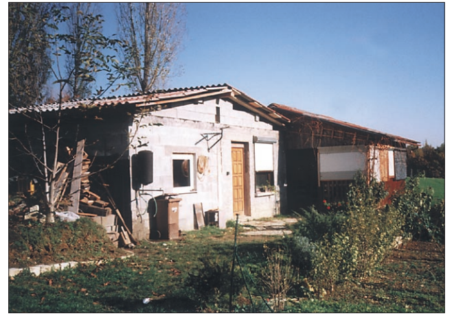
Dvosobna črno gradnja na Gomili. Stavba se je spremenila v kmetijsko zemljišče prve kategorije. Foto: V.Ž.
