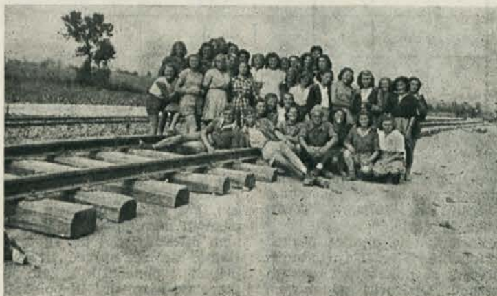
Na gradbišču proge
