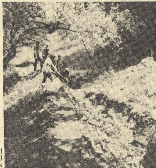
Polaganje Symalen cevi \varnothing 200 mm za vodovod Čeče—Hrastnik
