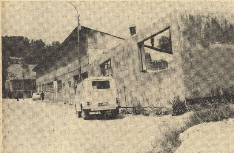
Zaradi plazov poškodovano poslopje »stare komunale« smo morali izprazniti
