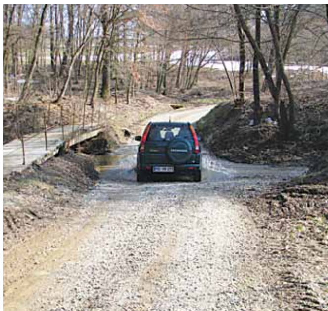
Sporna cesta preko Bogojinskega potoka je bila zaradi visokega vodostaja za promet zaprta od 28. februarja do 4. marca, le pet dni torej
