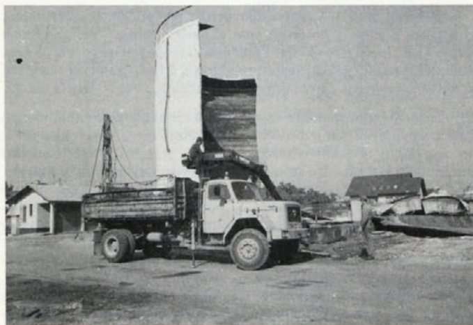
Podiranje rezervoarja za kislino
