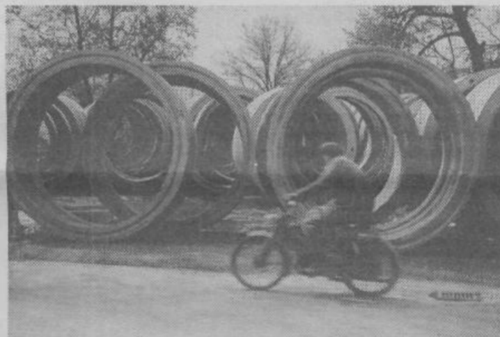
Ta posnetek je iz leta 1972, tedaj so skozni Moste gradili centralni kanal ljubljanske kanalizacije, ki sedaj zakopan pod nami zbira vse odplake Ljubljane, od Medvod do Zaloga. Kar velika je ta umazana reka, ki nevidno teče pod našimi nogami in brezbržnim daje občutek, da je za Ljubljano problem rešen (Foto: S. G.)
