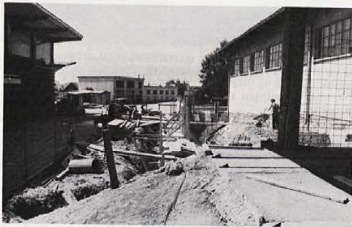
Dela pri razširitvi temperirnice dobro napredujejo
