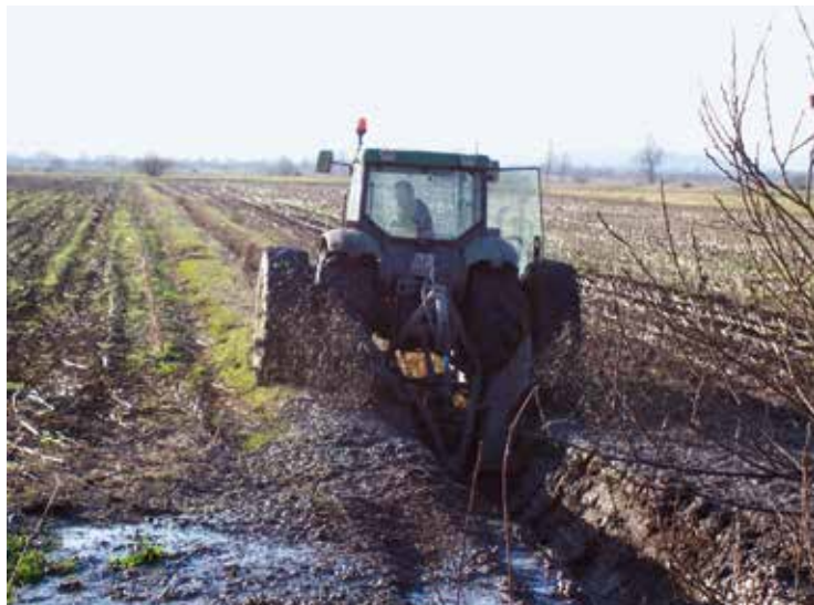
Strojno čiščenje jarka z frezanjem
