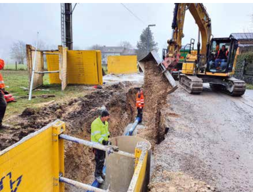
Gradnja kanalizacije in obnova vodovoda Iška vas-Iška
