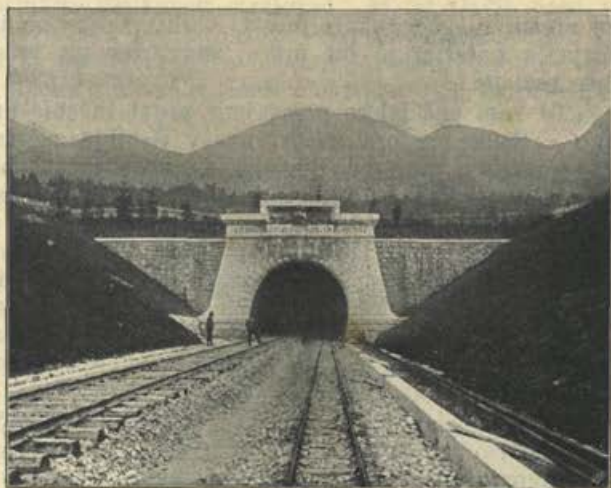
Vhod v bohinjski predor od severa. (A. Vengar.)
