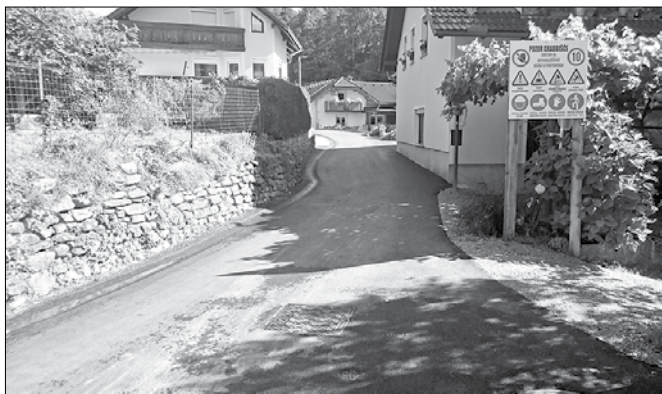
Prenovljena cesta Za Ljubnico (Fotodokumentacija Občine Ljubno)
