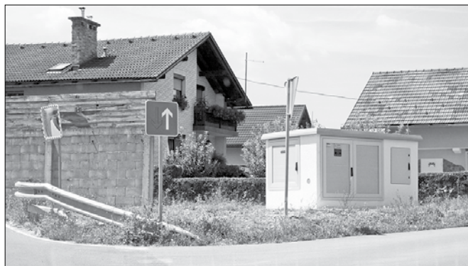
Bo s sodobno transformatorsko postajo na novi lokaciji zdaj mogoča izgradnja dvopasovne ceste? (Foto: Jože Miklavc)
