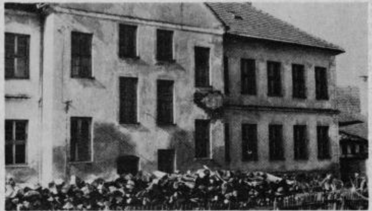
Zgradba šole v Markovcih
