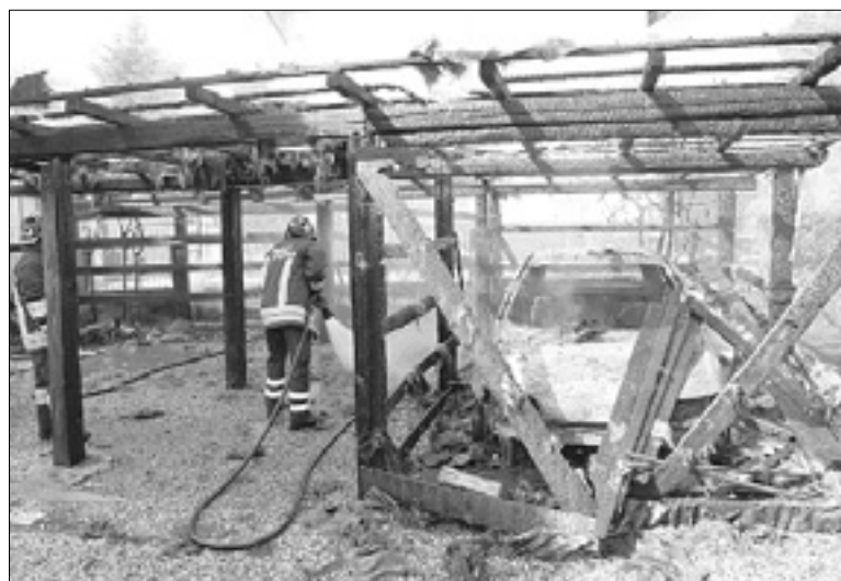
Gasilca med gašenjem nadstreška v Stražcah
