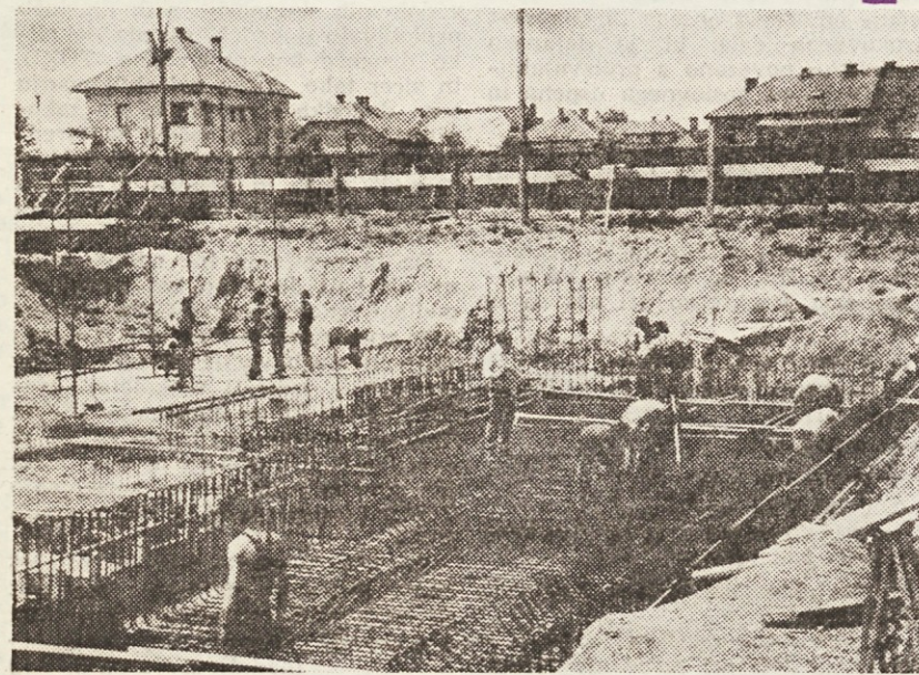
Betoniranje stebrov kleti
