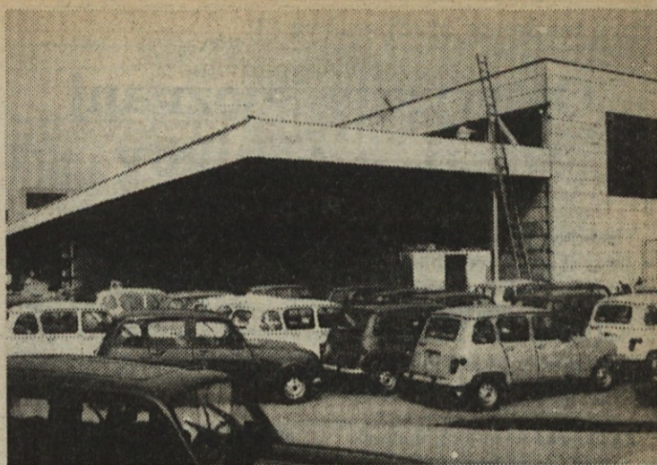
Nadstrešnica pri tovarni avtomobilov v Novem mestu je podaljšala proizvodno halo za deset metrov.
