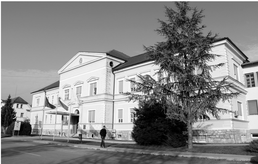
Slika 17: Južna fasada stavbe bolnišnice, okoli katere je pred gradnjo prizidka na vzhodni strani stala ograja (foto Ivanka Počkar).
