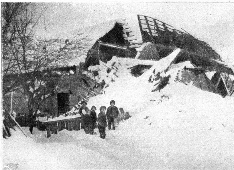
Slika 22: »Potres na Dolenjskem. Hiša Janeza Ivšiča iz Krške vasi št. 21 je popolnoma razsuta. Ko se je hiša porušila, je ubila in pokopala troje goved in posula Ivšičevega sina, ki so ga težko poškodovanega s težavo rešili izpod grobelj« (Ilustrirani glasnik, 15. 3. 1917).
