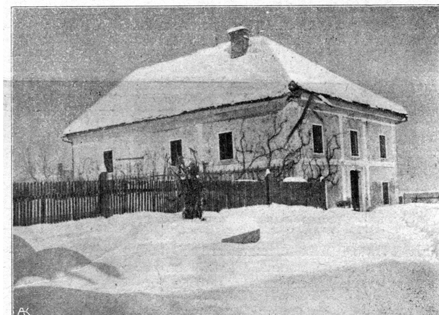
Slika 26: »Župnišče na Čatežu: Moč potresa se vidi iz tega, da je odbilo spodaj vogal pri strehi. V notranjosti je pa župnišče tako razruvano, da se bo moralo do tal podreti, kakor so to dognali državni inženirji« (Ilustrirani glasnik, 15. 3. 1917).
