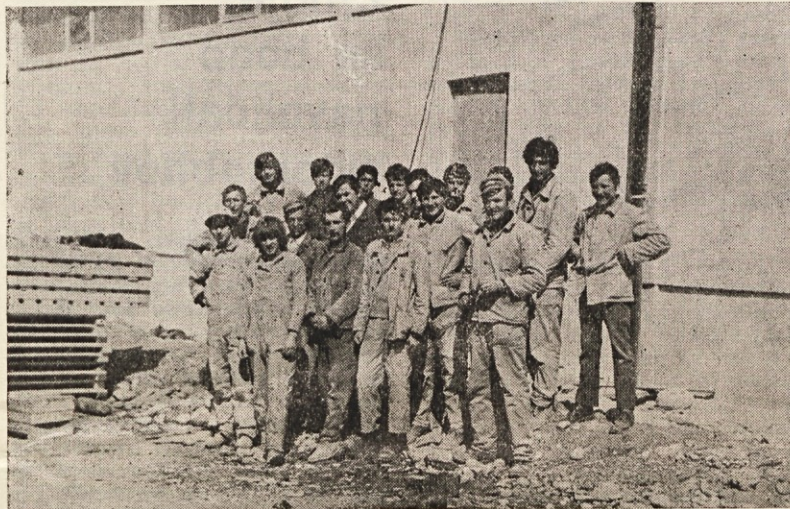
Delavci SGP graditelj Kamnik z delovodjem, ki so v zaključni fazi dograditve nove hale
