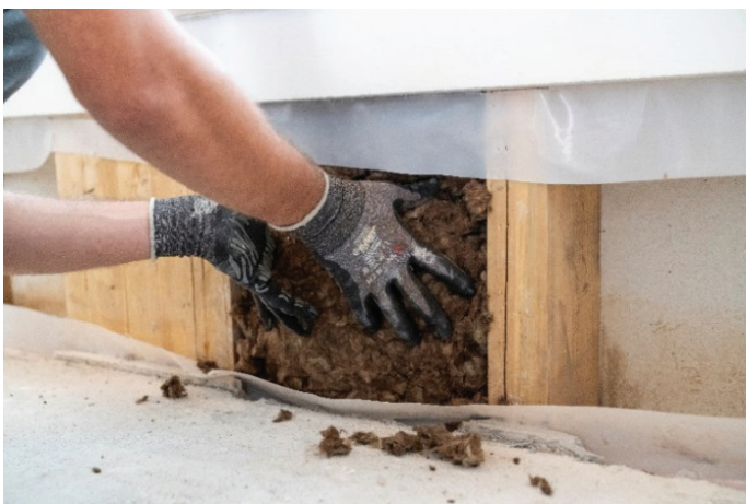
Slika 7. Vstavljanje izolacije, september 2023.
