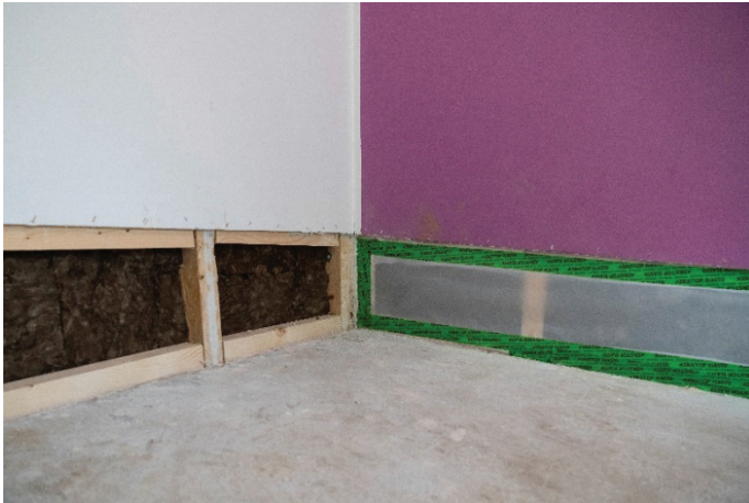
Slika 9. Prikaz vzpostavitve zrakotesne ravnine, s katero mora biti sklenjen celoten ovaj hiše, september 2023.
