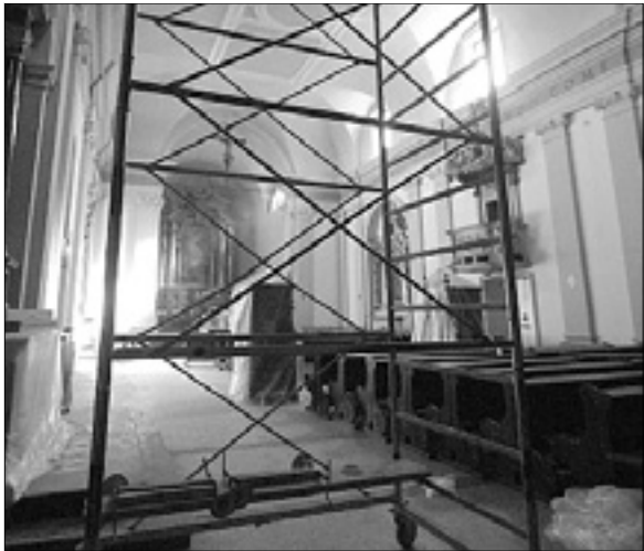
Po koncu obnove so delovni oder odstranili BONAVENTURA
