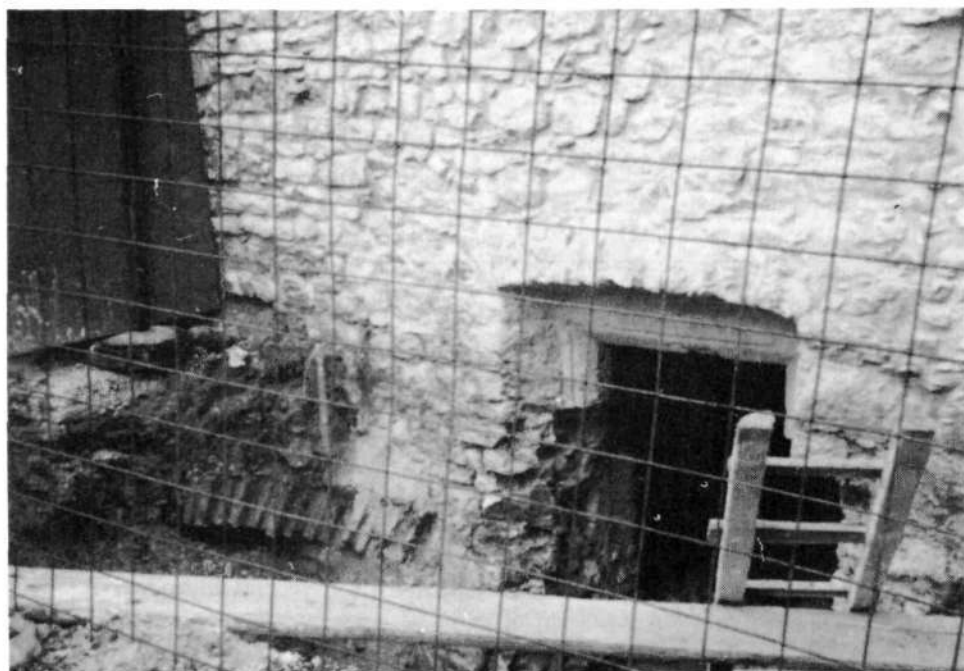
Spomladi 1995 je bila ob kletnem oknu Kašče na južni strani skopana gradbena jama do nivoja kletnih tal. Pri tem so bili približno 0,75 m pod nivojem dvorišča odkriti obokani in ometani prostori, ki so bili zaradi nedovoljenega gradbenega posega nato zasuti
