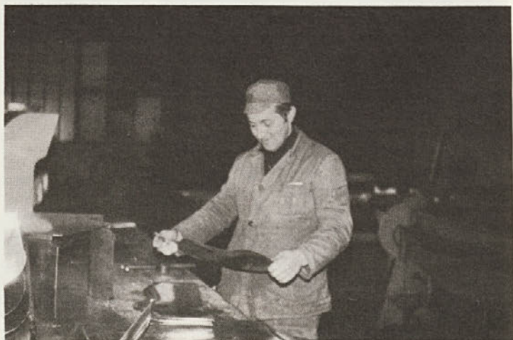
Jože Škedelj, klepar pri izdelovanju prezračevalnih kanalov.
