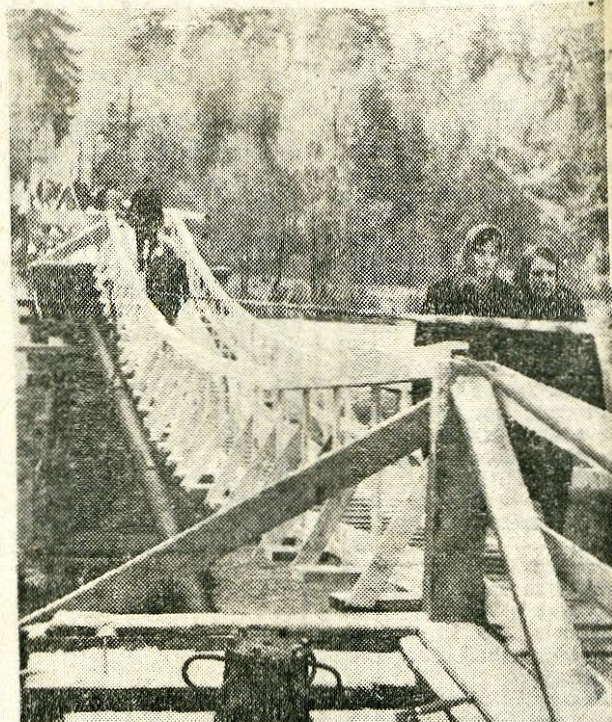
ZASILNA BRV, ki so jo naredili pred novim letom na odplavljenem mostu pri Tekstilindusu v Kranju je sicer delavcem precej skrajšala pot, vendar pa je res le »zasilna« in bi jo bilo potrebno ob višji vodi zaradi varnosti zapreti. — Foto: F. Perdan
