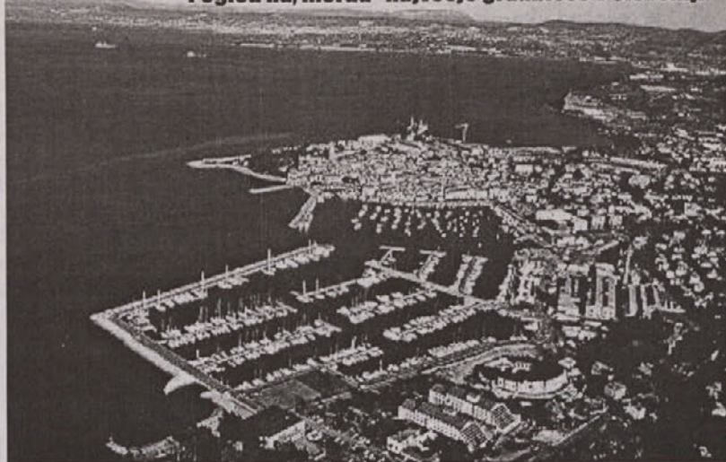
Pogled na, morda "največje gradbišče v Sloveniji"
