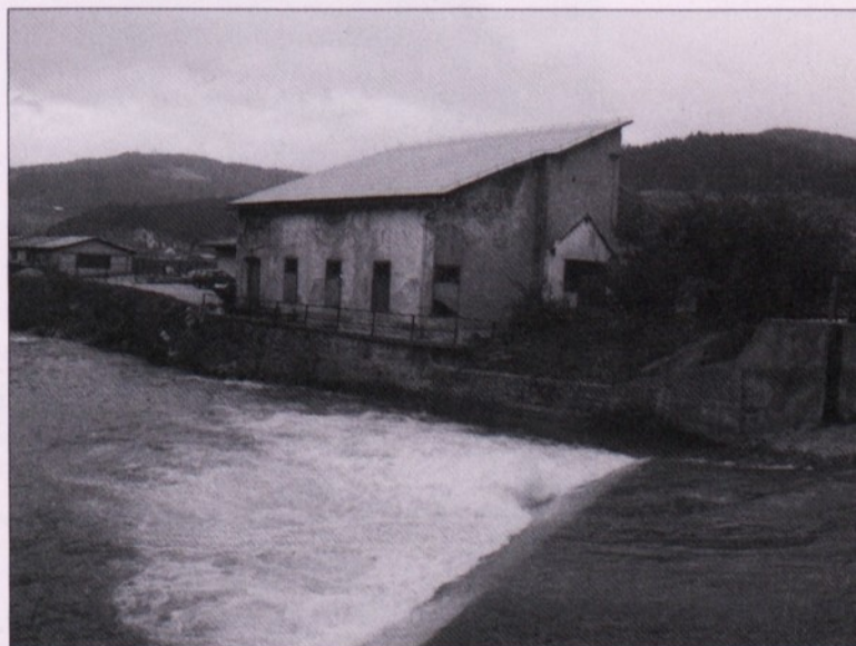
Poslopje opuščene mestne elektrarne v Pamečah (2003)
