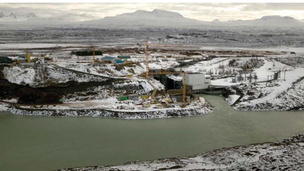
Gradbišče HE Lagarfoss - Islandija
