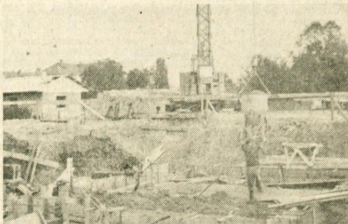
Zavod za stanovanjsko izgradnjo je pričel ob Kamniški cesti v Domžalah graditi tri »stolpiče«, t. j. petnadstropne stanovanjske bloke. Dela je prevzelo Gradbeno podjetje Domžale, ki si je v ta namen nabavilo tudi moderno transportno dvigalo, ki se za sedaj še visoko dviga nad gradbeno jamo, kjer betonirajo temelje za prvega od treh objektov.
