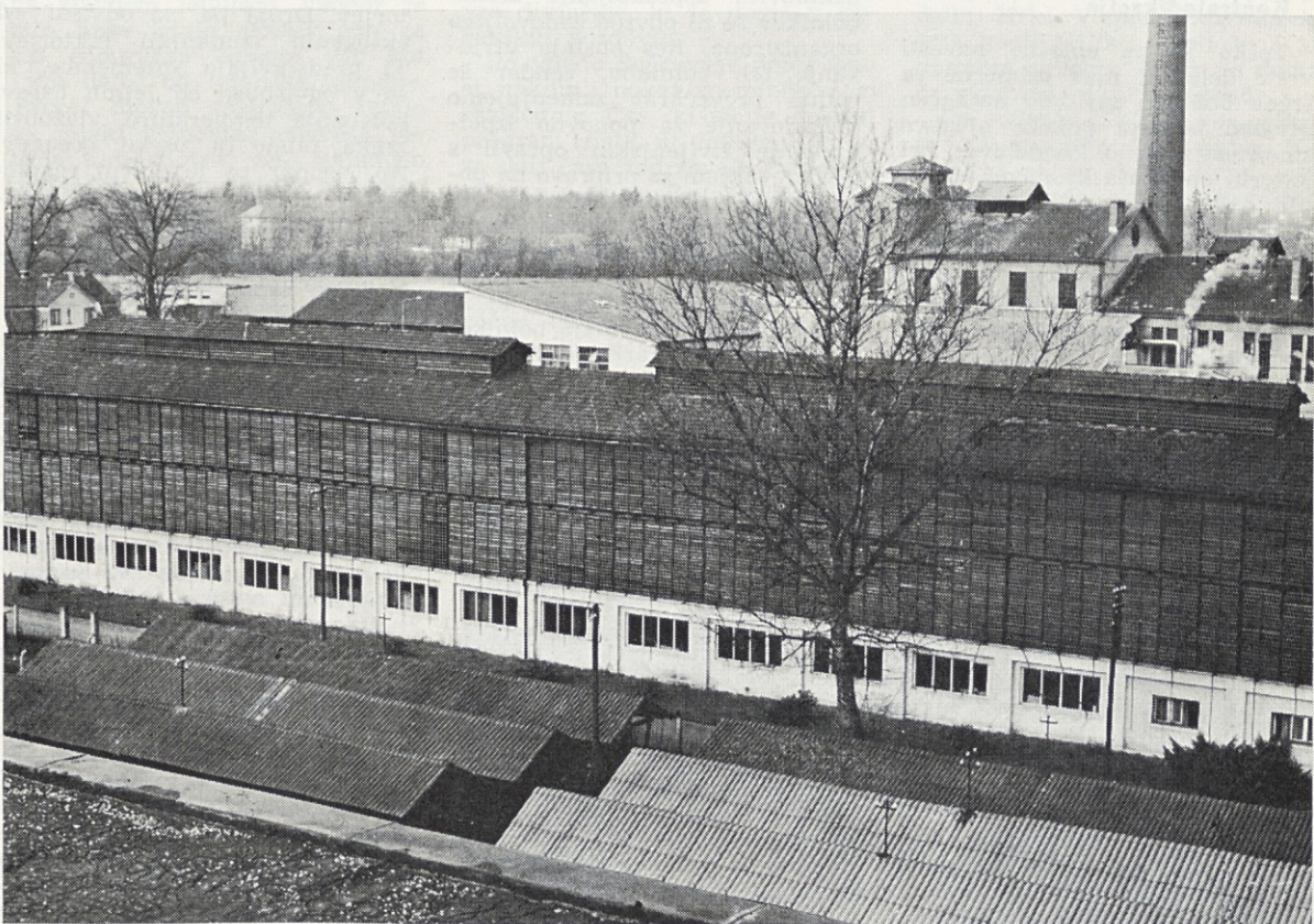
Pogled na zračno sušilnico
