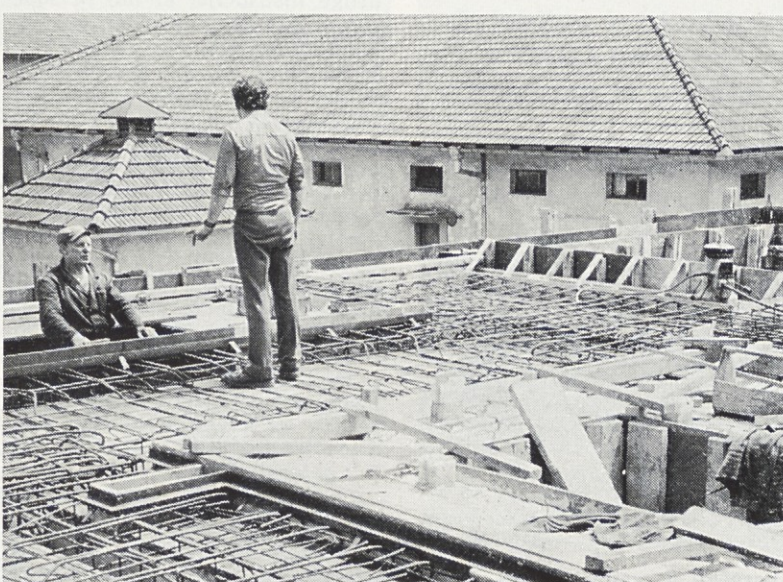
Armatura plošče strojnice parne turbine je položena
