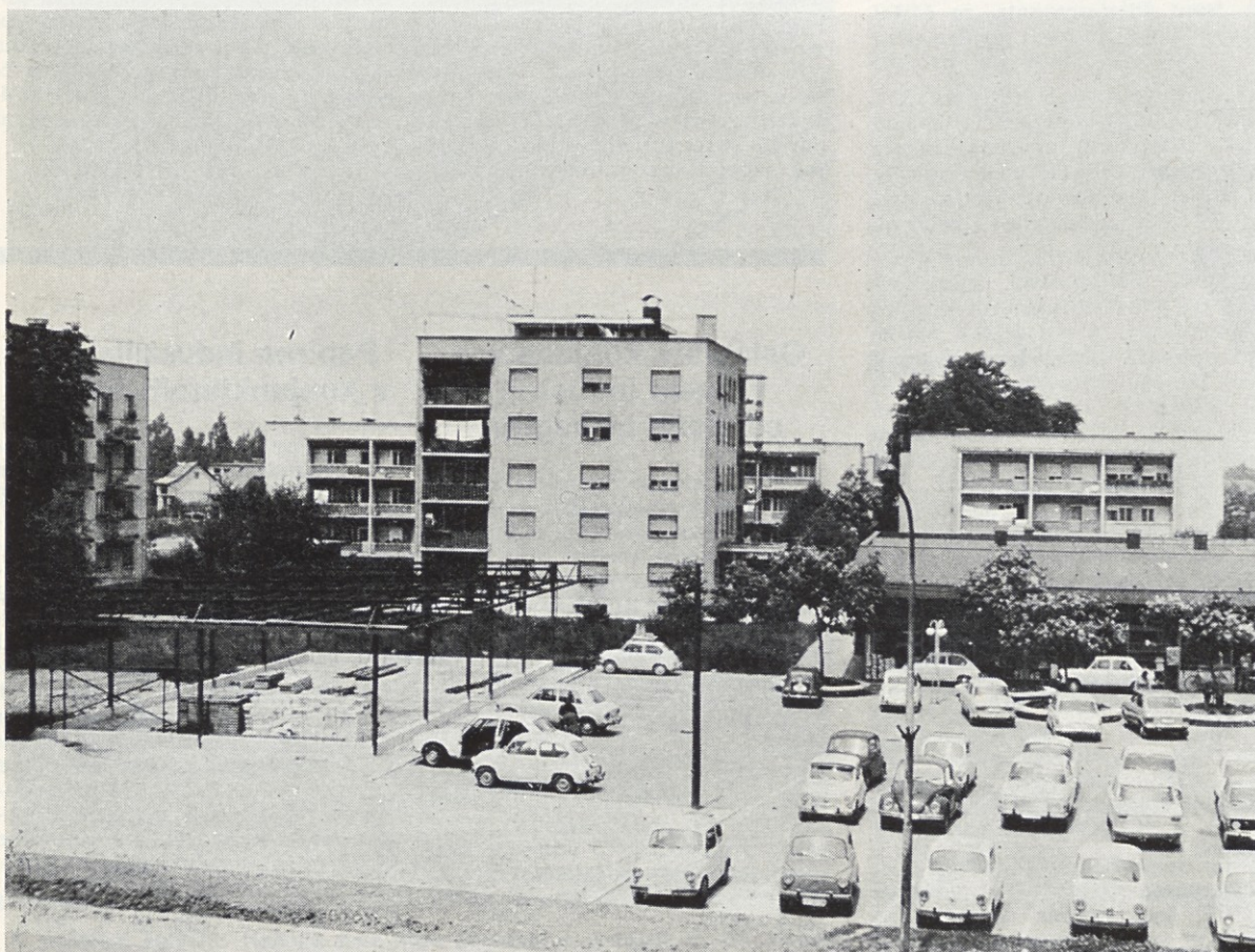
Kovinsko ogrodje že stoji, dela pa se nadaljujejo (9. 6. 1975)
