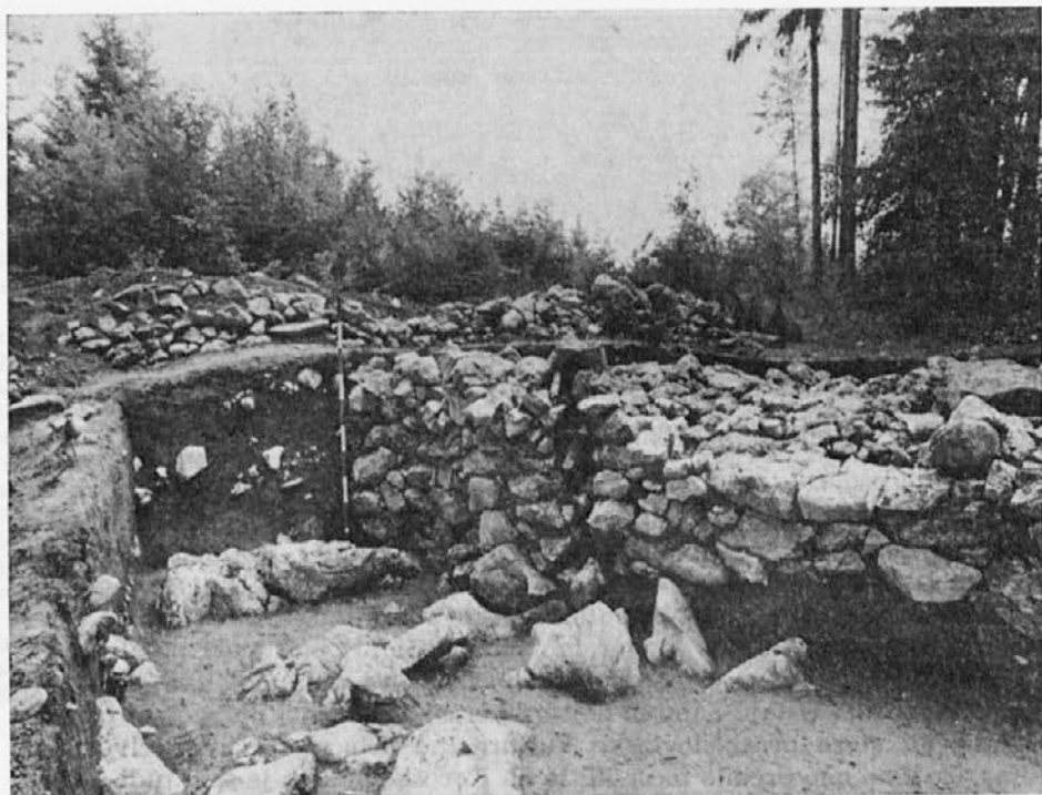
Stična. Pogled na obzidje železnodobne naselbine.
