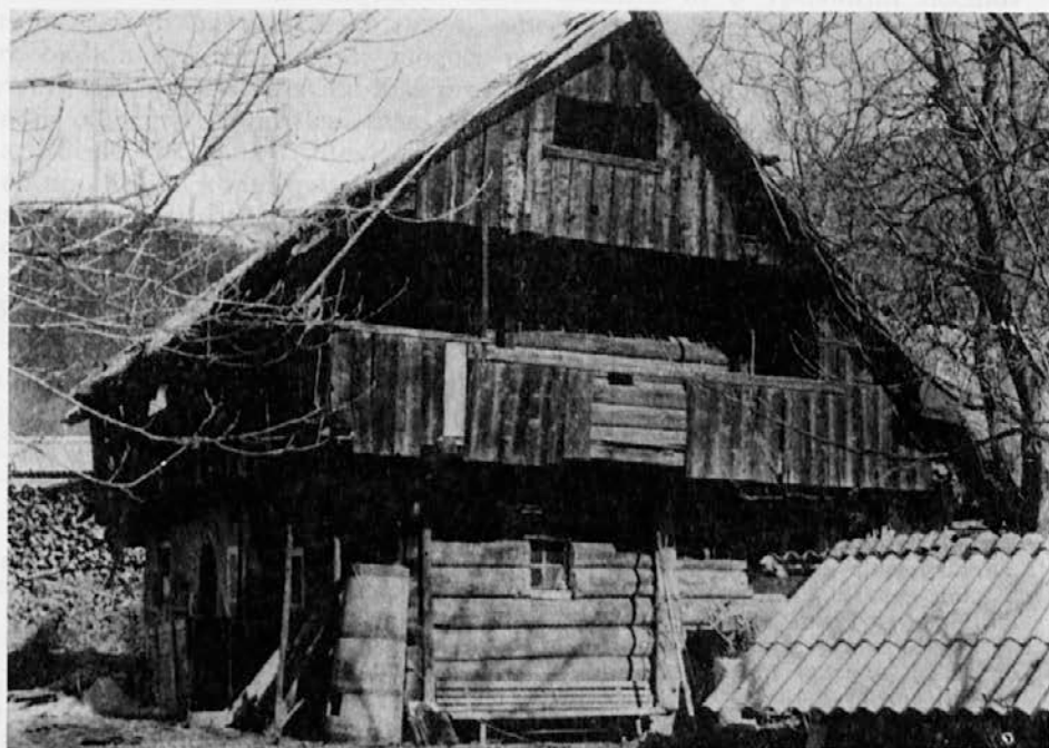
Sl. 13: Nadstropna kmečka hiša alpskega tipa iz konca 17. stoletja, Poženk št. 1, porušena 1990. Foto: T. Cevc.
