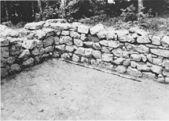
Sl. 44: Zgornja cerkev. Način gradnje zidu v severozahodnem vogalu ladje.
