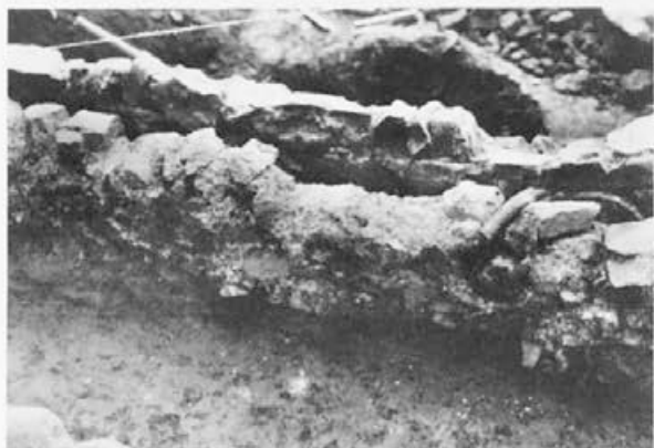
Sl. 116: Velika stavba. Dvorana, kanal centralne kurjave, detalj. Abb. 116: Großes Gebäude. Saal, Zentralheizungskanal, Detail.
