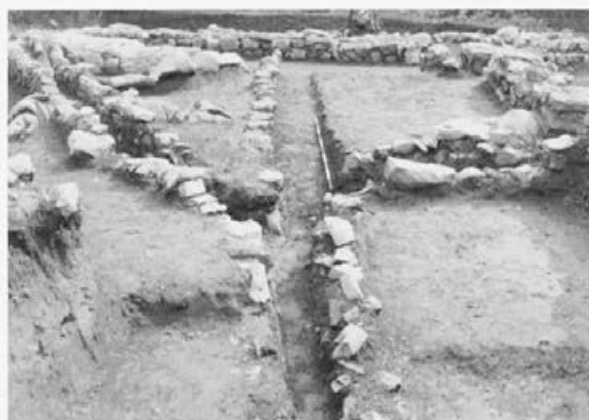
Sl. 121: Velika stavba. Dvorana, razvod kanalov centralne kurjave.
