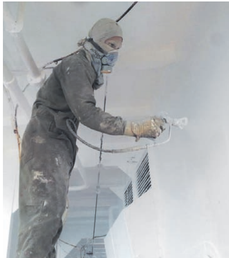
Med plovbo posadka ladja ves čas obnavlja in pri tem vsak poprime za vsako delo.
