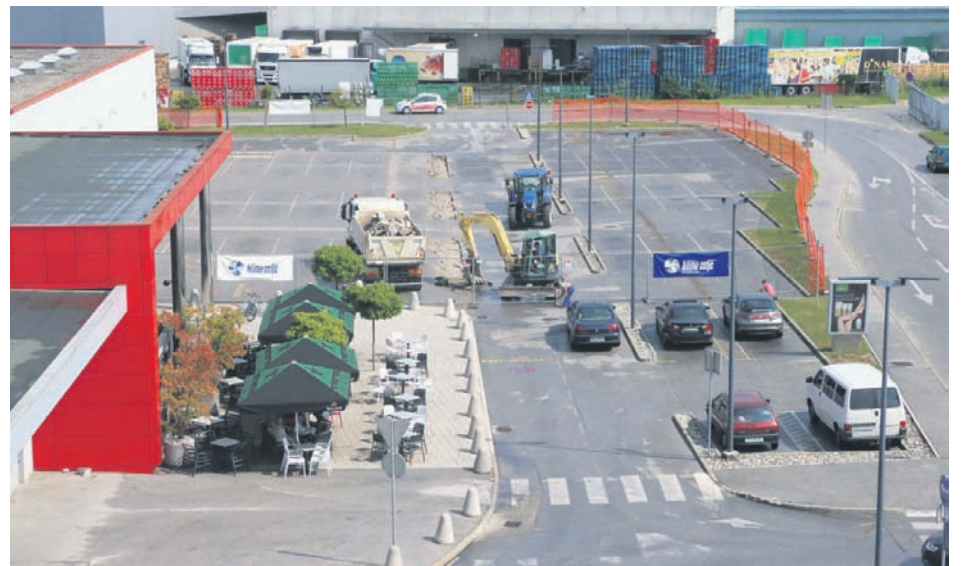
Delavci so v Citycentru preurejali tudi zunanja parkirišča.
