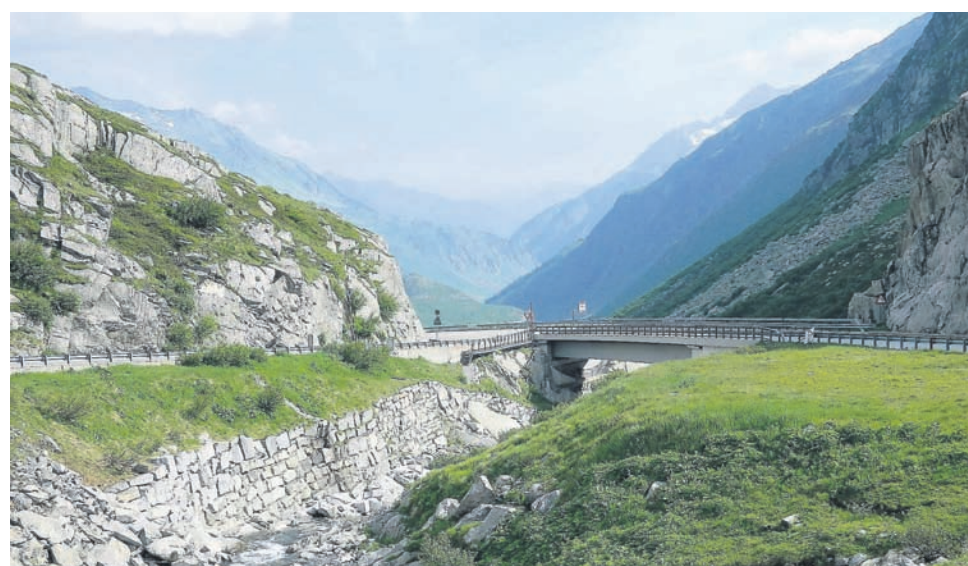
St. Gotthard, v smeri Andermata, stičišče stare in novejšje ceste čez prelaz
