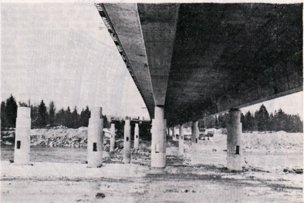
Most čez Savo med Tomačevim in Črnučami je sestavljen iz dveh samostojnih delov, na vsakem bosta po dva vozna pasa, na desnem pa še pločnik in kolesarska steza. Celoten most bo končan junija letos
