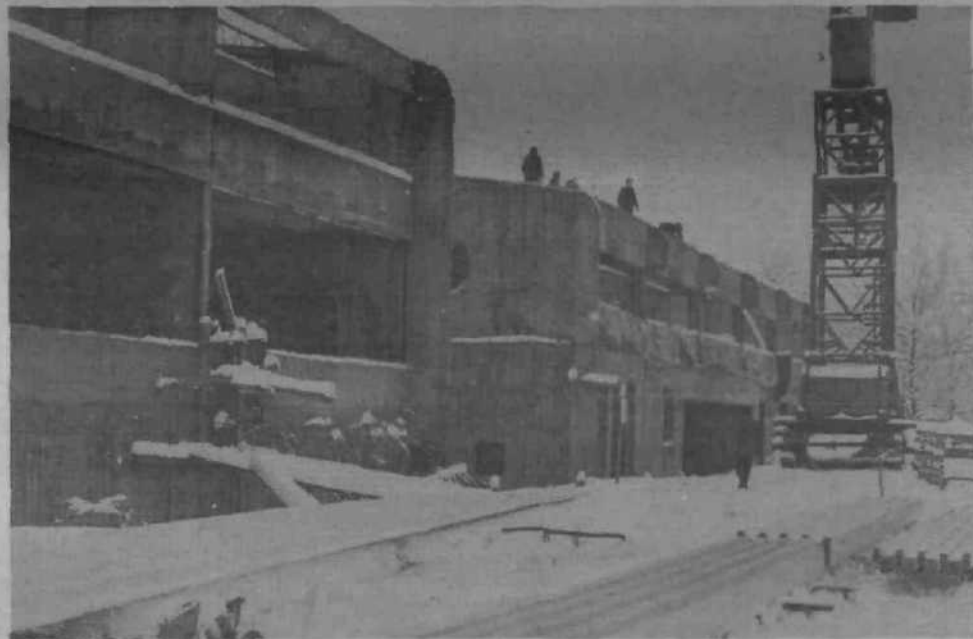
Še ne do kraja zgrajeno novo črnuško šolo je prekril sneg. To pa ne bo ovira, da ne bi bila šola zgrajena do zagotovljenega roka. Na nedavni seji gradbenega odbora je bilo slišati, da je terminski načrt za storitve realen in da bodo vsa dela opravljena v določenih rokih. Tako bo s šolskim letom 1978-79, ko se bodo odprla vrata nove šole, končno rešen pereč problem šolanja črnuških otrok.
