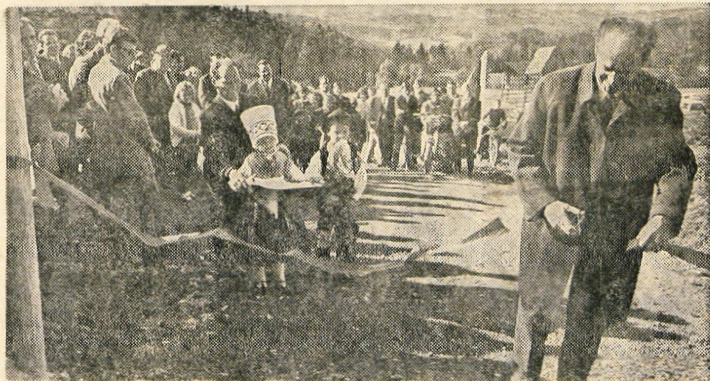
Gradnja okrog 5,5 km dolgega odseka nove ceste Stiška vas — Ambrož je veljala prek 30 milijonov starih dinarjev. V nedeljo jo je slovesno odprl predsednik kranjske občinske skupščine. — Foto: F. Perdan
