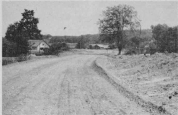
Cesto proti Destrniku (odsek ceste Ptuj—Lenart) modernizirajo. Foto: R
