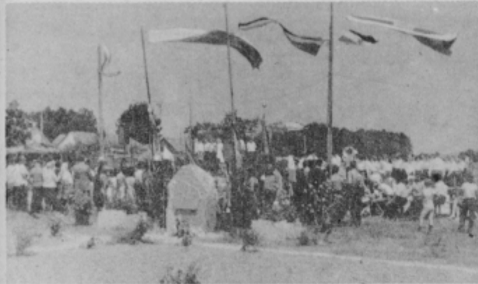
Proslava v Prvencih je bila ob spomeniku padlim kurirjem in na temeljih bodočega kulturnega doma, ki so že zabetonirani.
