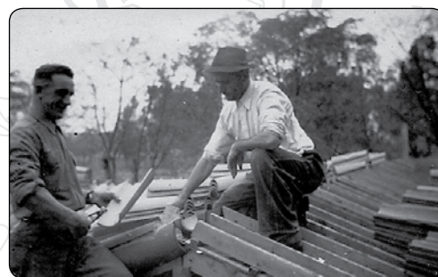
Delo na strehi / Construyendo el techo
