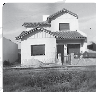
Hiša skoraj končana / La casa casi terminada
