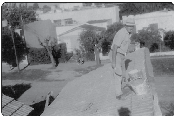
Ata zida novo hišo na cesti Kennedy, v V. Luzuriaga / Papá Vinko. construyendo la nueva casa en la calle Kennedy, en V. Luzuriaga
