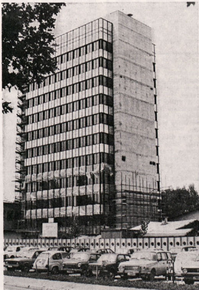
TOZD Gradbena operativa Ljubljana: V gradnji objekt za Ljubljanske mlekarne. Foto: Vili Suster
