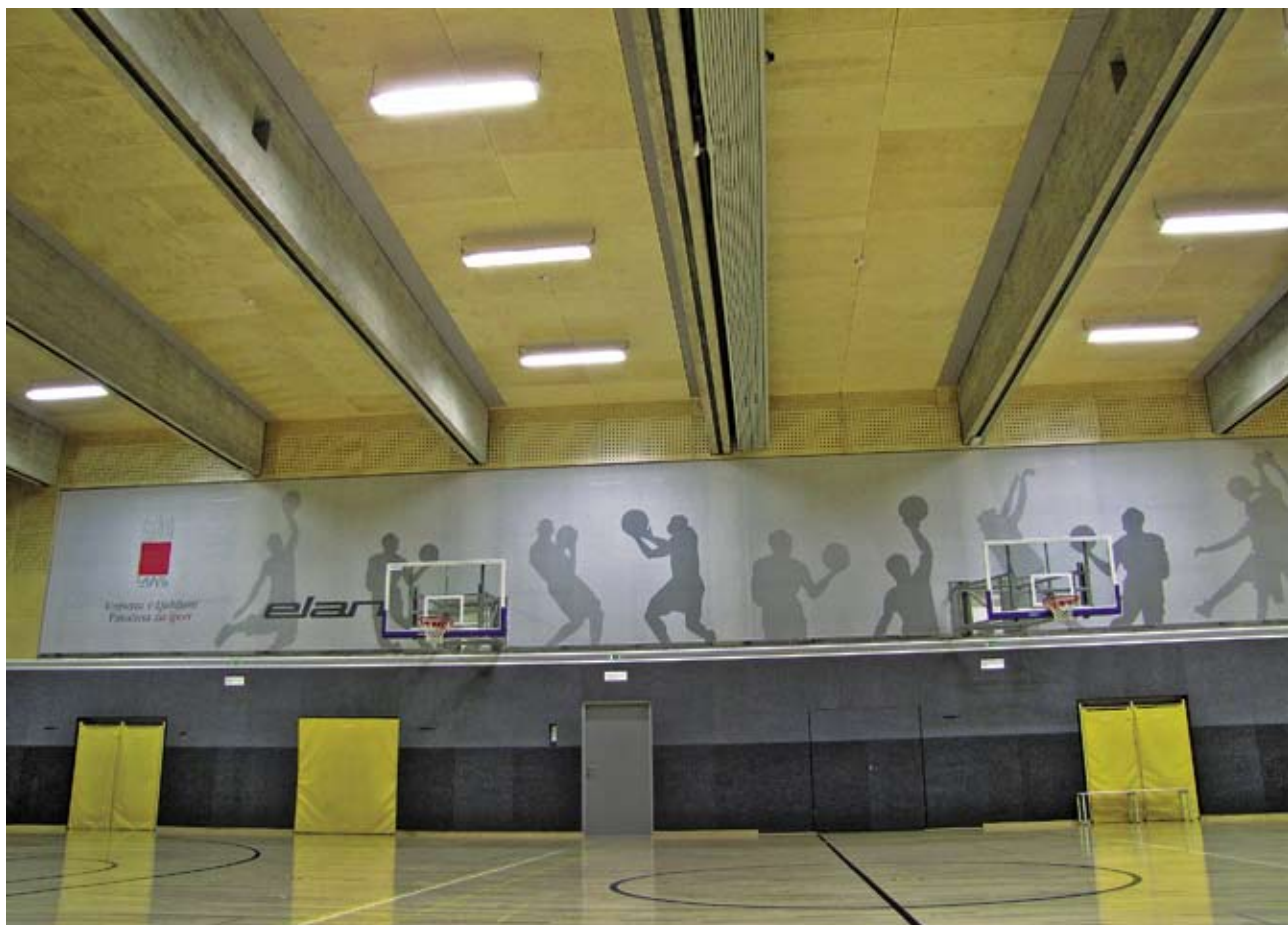
Slika 2: Akustične stropne in stenske obloge v športni dvorani Krn.
