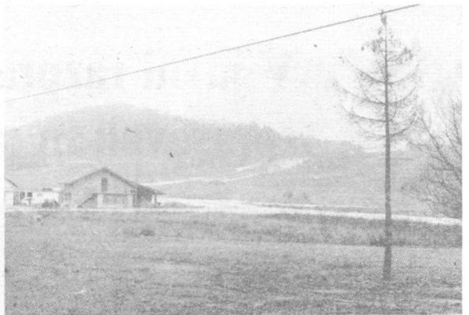
Pogled na cesto Škofljica-Gumnišče-Glinek
