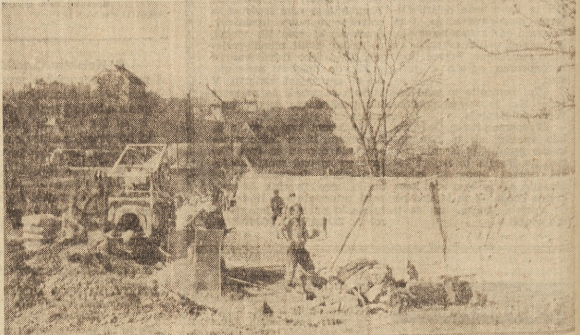
V Čatežu ob Savi dograjujejo obrambni zid, ki bo zavaroval pred poplavi cesto, ki od Brezice vodi na avto cesto oziroma proti Čateškim Tokilcam Foto služba DE
