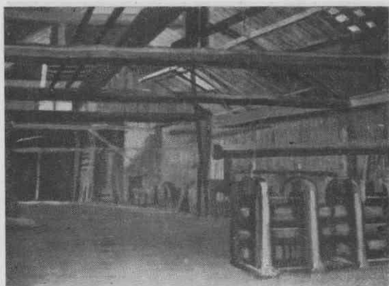
Notranjščina valjavnice na Jesenovcu s štirimi stavki valjev
