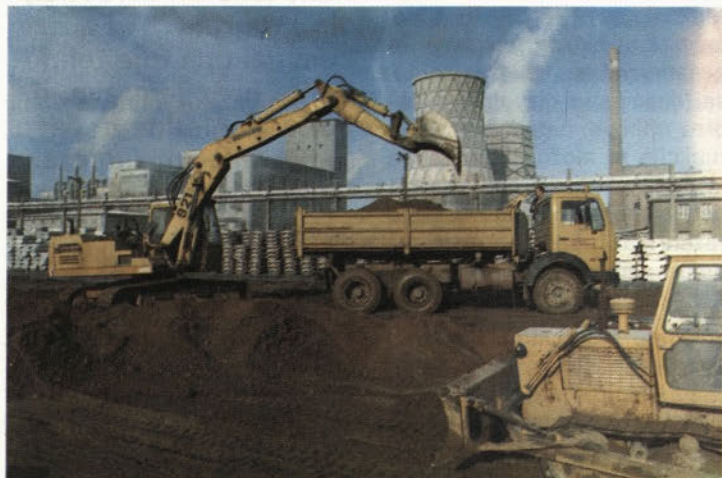
Začetek zemeljskih del
